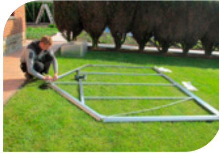
2. Monteer zijgevels en kopgevels
