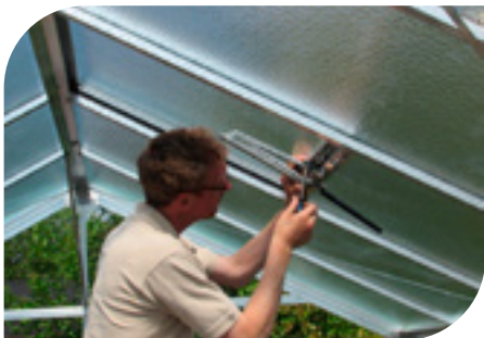
7. Plaats deur en ramen
