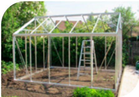
4. Plaats de nok en glasregels van het dak
