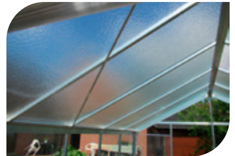
6. Schroef alle bouten en trekklatten aan
